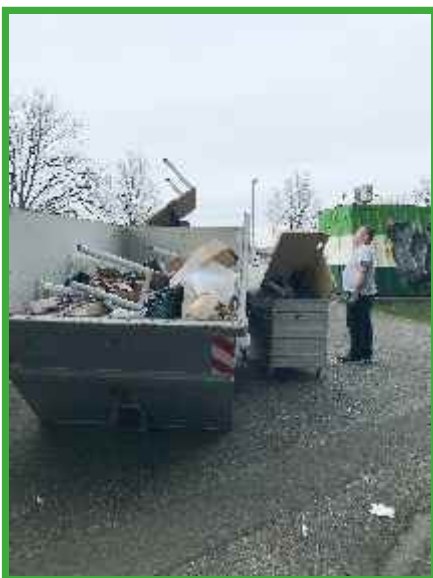
Renovieren im Fanprojekt
